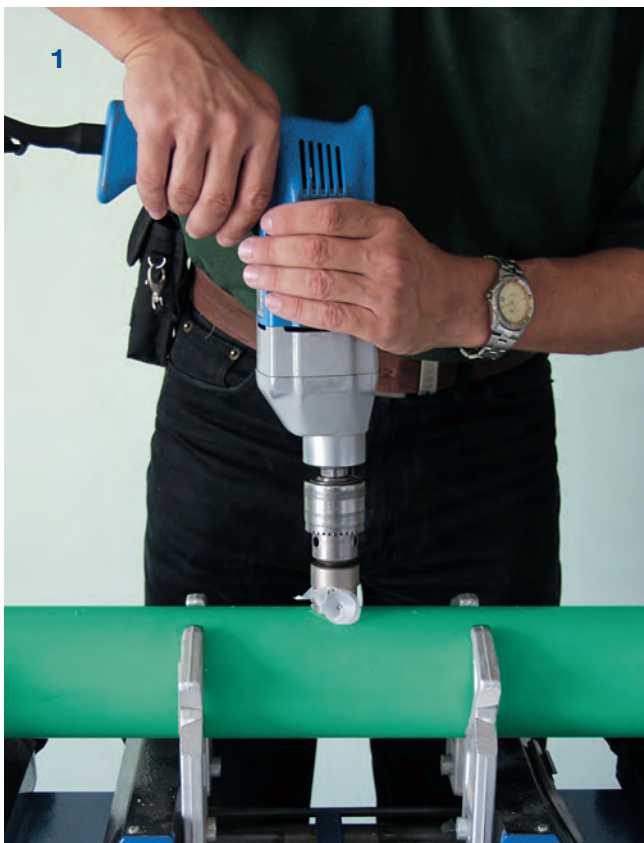
1 Marcare sulla tubazione il punto in cui creare la diramazione e forare con apposita fresa.
